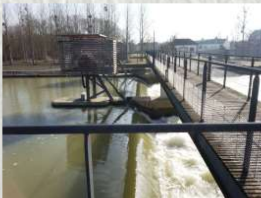
Barrage de Jaulnes – Photo ST ©
