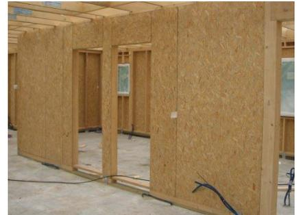
*Panneaux de particules utilisés dans la construction*
